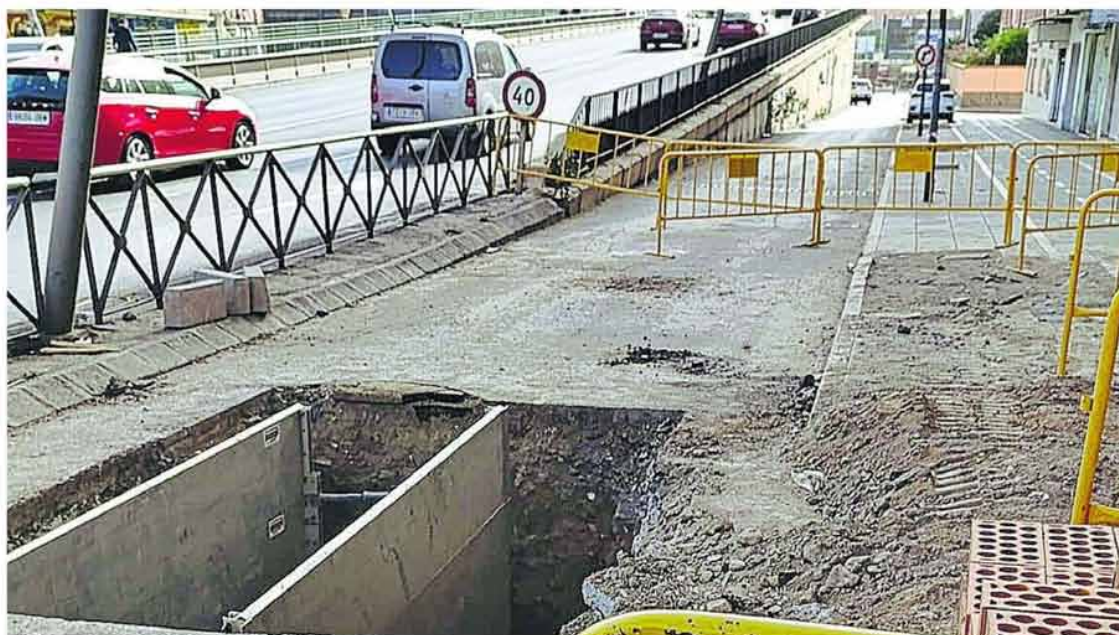
Tramo de las obras del AVE en Almería. Europa Press
