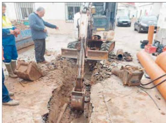
TRABAJOS. Cambio de tuberías en la barriada de la Estación Linares-Baeza.
