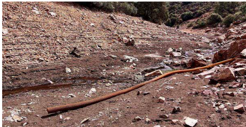
La presa de Río Frío, sin caudal en una fotografía sin fecha, en una situación parecida a la actual.
