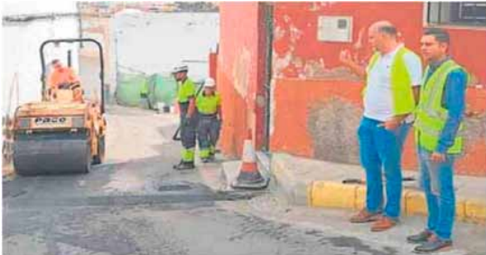
El concejal Juan Francisco Jiménez acudió a supervisar las obras. c7
